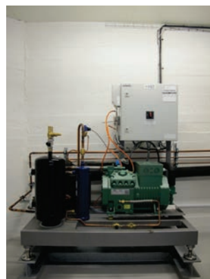
Detta är kompressorn och ispannan i det nya isverket. Lasse har monterat av skyddsväggarna för ispannan så att maskinen syns.
