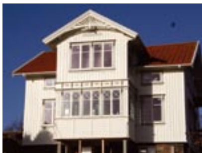
Byggt 1914, renoveras nu till originalskick.
