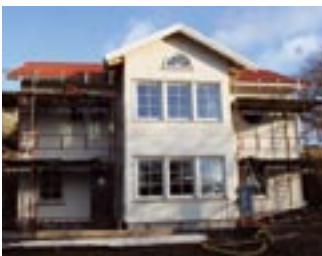
Ytterligare ett hus är rest på Lyckebovägen
